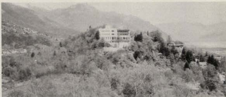
Das 1928 von Architekt Emil Fahrenkamp erbaute Hotel Monte Verità, aufgenommen um 1930. Von der Heydt veränderte wohl die Bausubstanz grundlegend, achtete aber darauf, eine Art Gesamtkunstwerk im Wagnerschen Sinn zu erhalten. Darauf deuten verschiedene Stellen auf dem Gelände hin, die zum Beispiel Parzifal-Wiese oder Walküre-Felsen genannt wurden.
